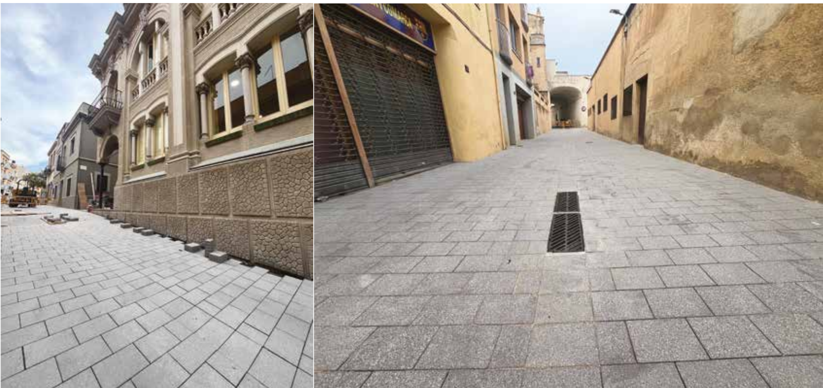
Obres finalitzades al carrer del Molí i al carrer del Pont.
